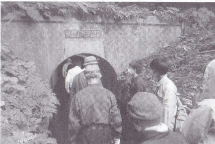
図6 戸ノ口堰洞門くぐり
